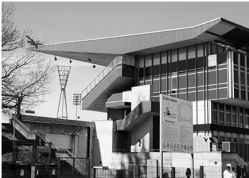
Jahnstadion: vom Abriss bedroht
