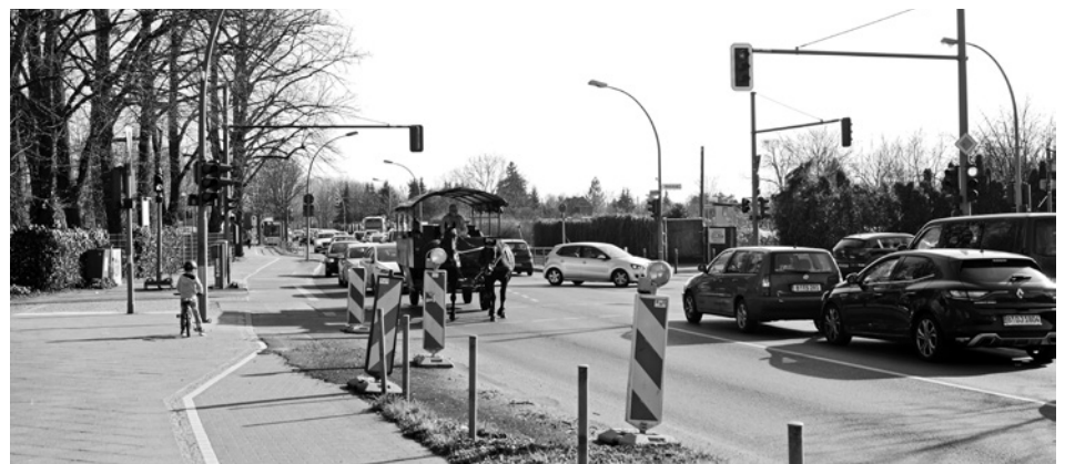
Krugstege / Bahnhofstraße in Blankenburg
