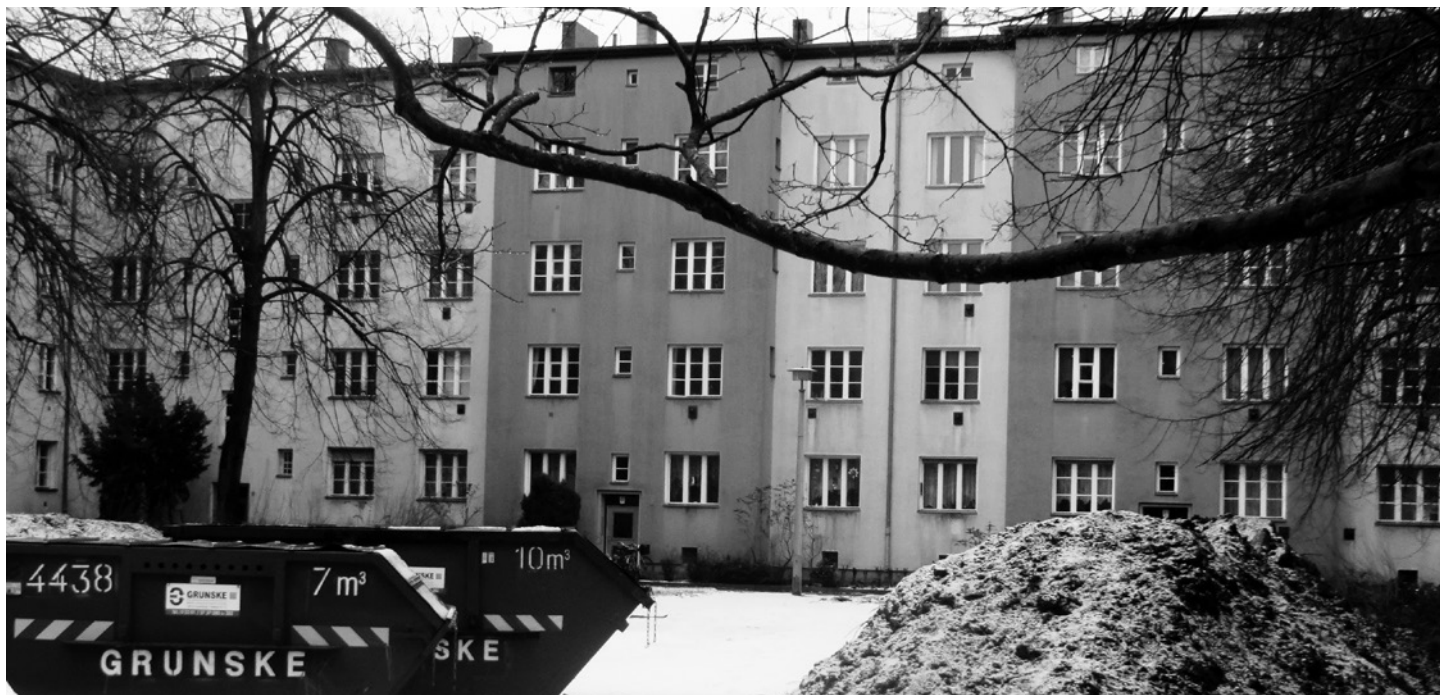
Wohnkomplex an der Schönstraße in Weißensee vor der Sanierung
