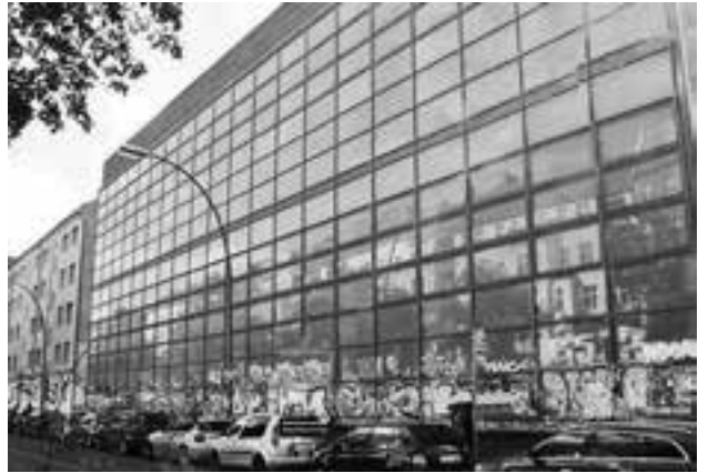
Freigezogene Turnhalle Wichertstraße
