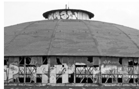
Lokschuppen am S-Bhf. Heinersdorf
