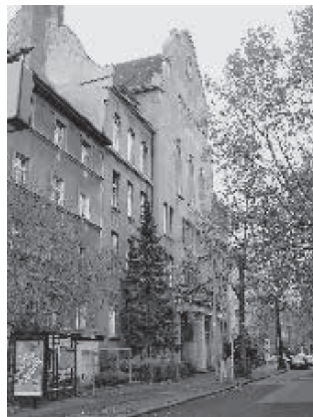
Rosa-Luxemburg-Gymnasium in der Kissingenstraße
