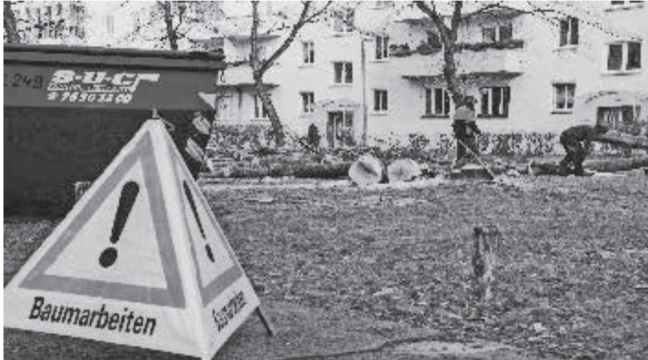
Die Fällung von über 40 Bäumen bildet den Auftakt für den Bau einer Tiefgarage mit 200 Stellplätzen
