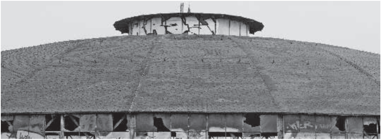
Lokschuppen am S-Bahnhof Heinersdorf
