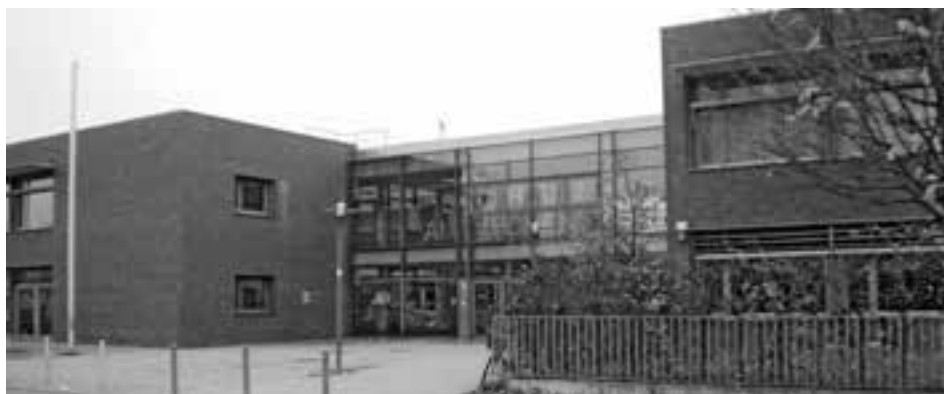
Grundschule am Hohen Feld in Karow
